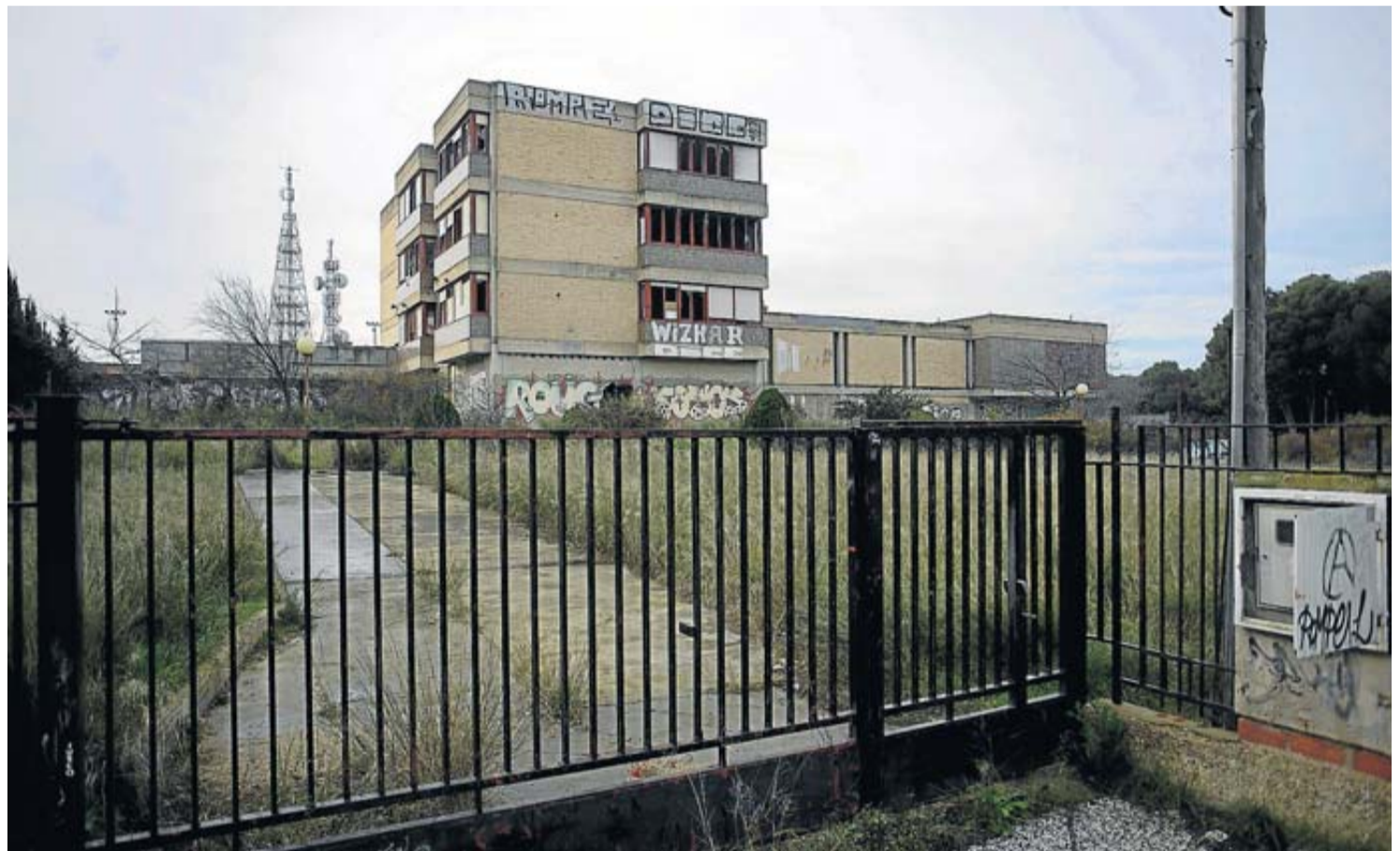
El antiguo colegio, situado junto a los pinares de Venecia, muestra en la actualidad un estado ruinoso. FRANCISCO JIMÉNEZ
